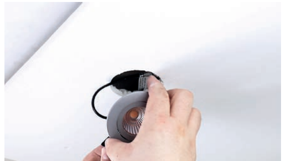
5 - Einsetzen des Spots in den Deckenausschnitt
